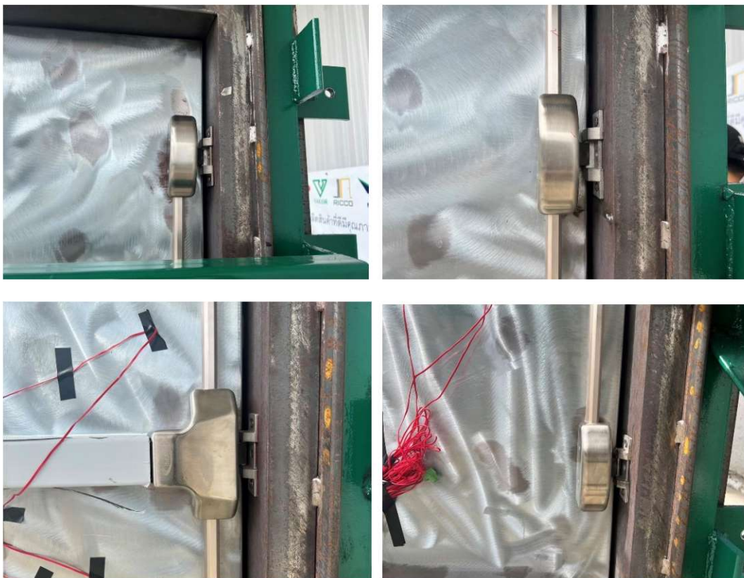
รูปที่ 2 ตรวจสอบความเสียหายบริเวณสลักหลังทำการทดสอบ
